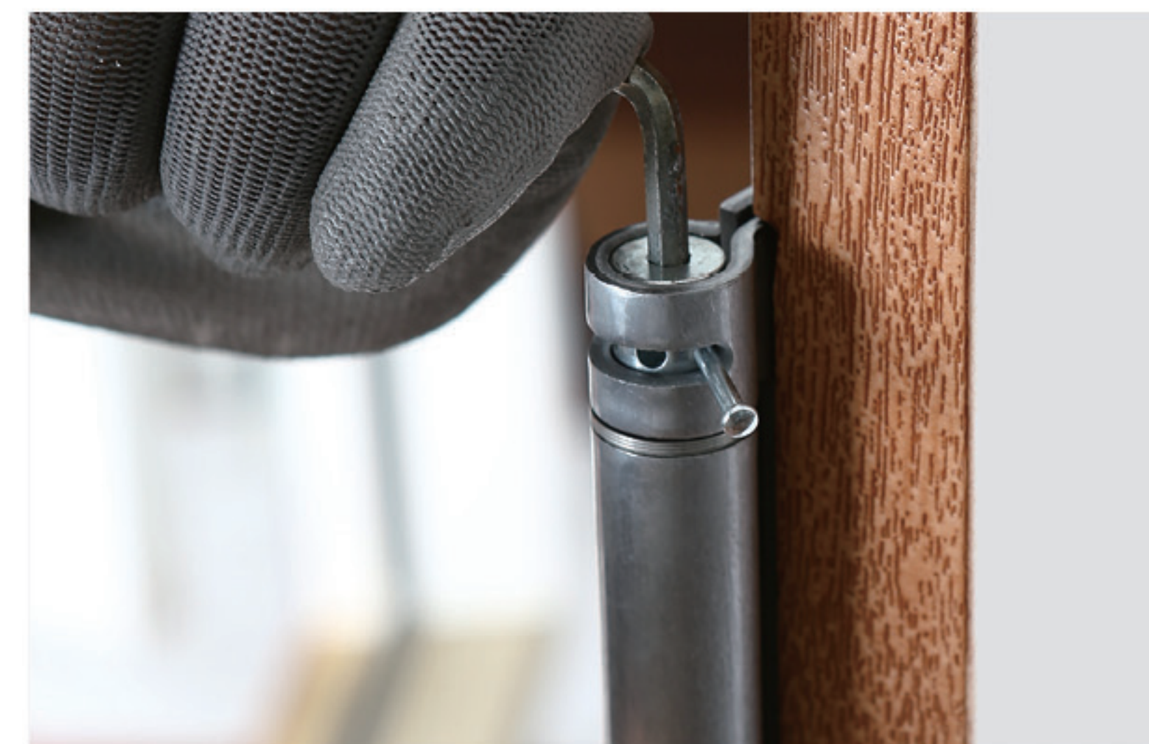
04. 육각 렌치가 설치된 상태에서 구멍에 고정 핀으로 고정합니다. (사용 중에 조절 시 반복합니다.) ※ 사용 중 소음 발생시 액체윤활류 도포를 권장합니다.
